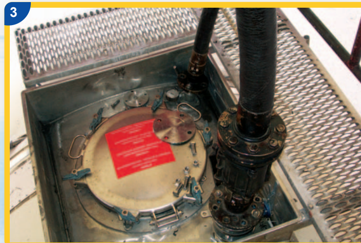
Riempimento del tank container tramite condotta di compensazione del gas presso lo stabilimento chimico in Spagna.
